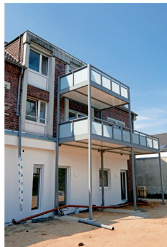
Im Zuge der Umbauarbeiten im Erdgeschoss wurden auch für die Wohnungen im 1. und 2. Obergeschoss erstmalig großzügige Balkone angebaut. Hierzu wurden u.a. nachträglich bodentiefe Balkontüren in die Bestandswohnungen eingebaut. Es folgen zudem noch ein neuer Unterstand für die Fahrräder sowie ein kleiner Spielplatz.
