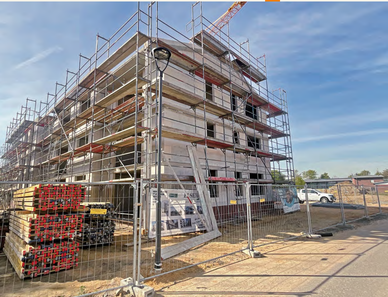
Der 1. Bauabschnitt an der Florianstraße im Rohbau
