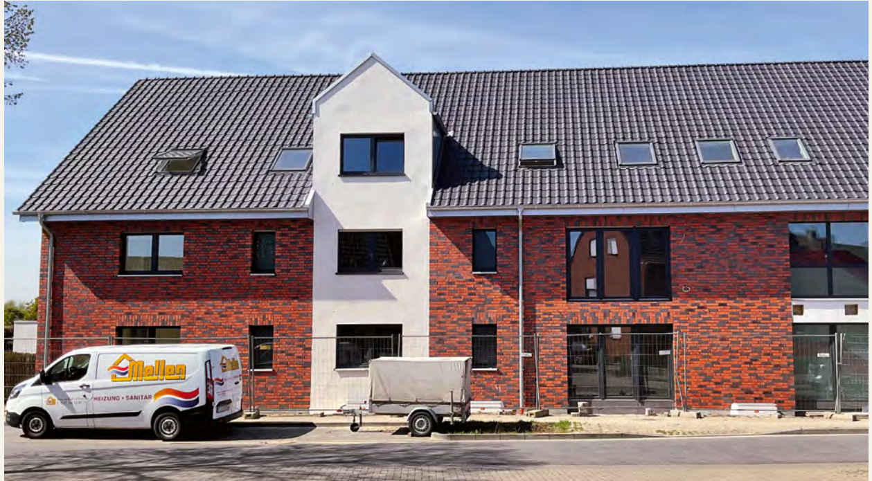
Der Neubau an der Hunsbrückstraße soll am 01.08.2022 bezugsfertig sein.
